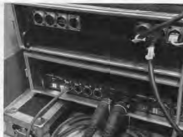
劇場側では、映像信号と音声信号を統合し、ルーターへと送るネットワーク・スイッチには Luminex「GigaCore10」を使用
